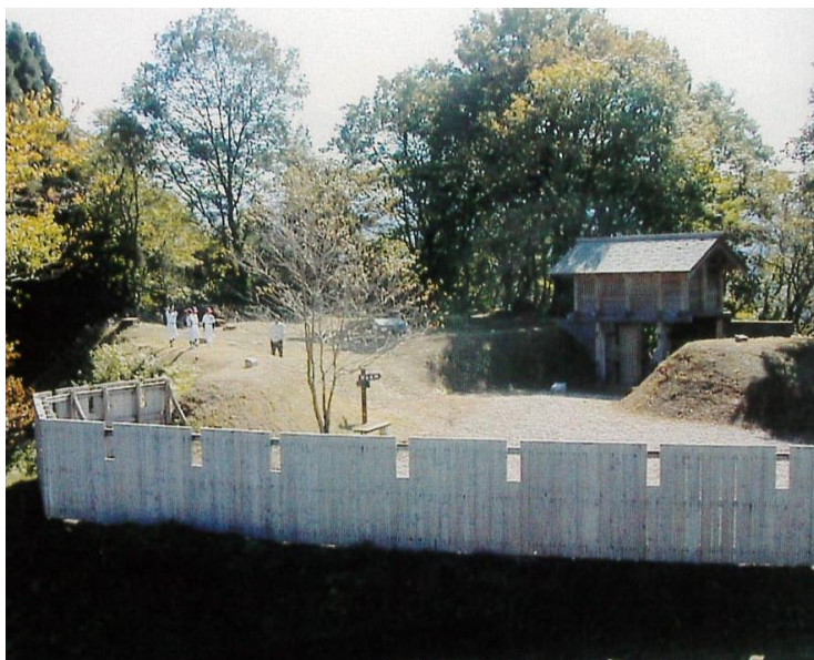
復原された中の丸門と板塀
